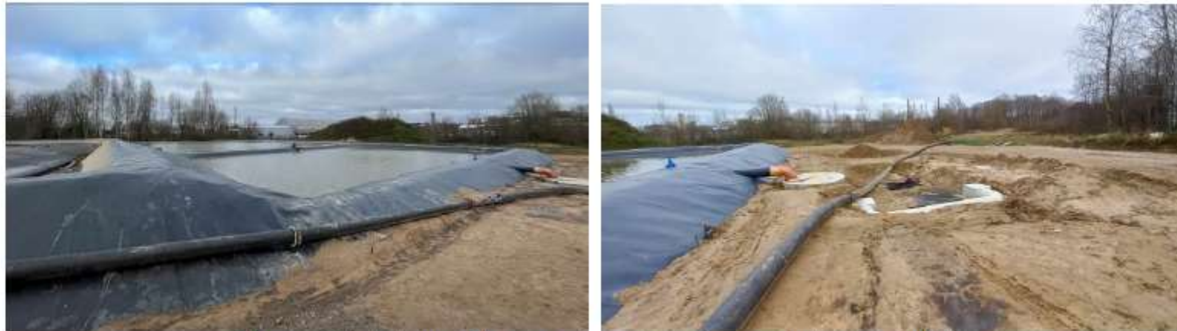
13 pav. Slėginis dumblo vamzdynas ir naftos produktų gaudyklė.
