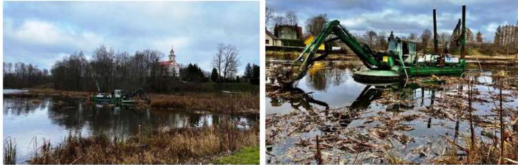
10 pav. Užteršto grunto siurbimas žemsiurbe.
