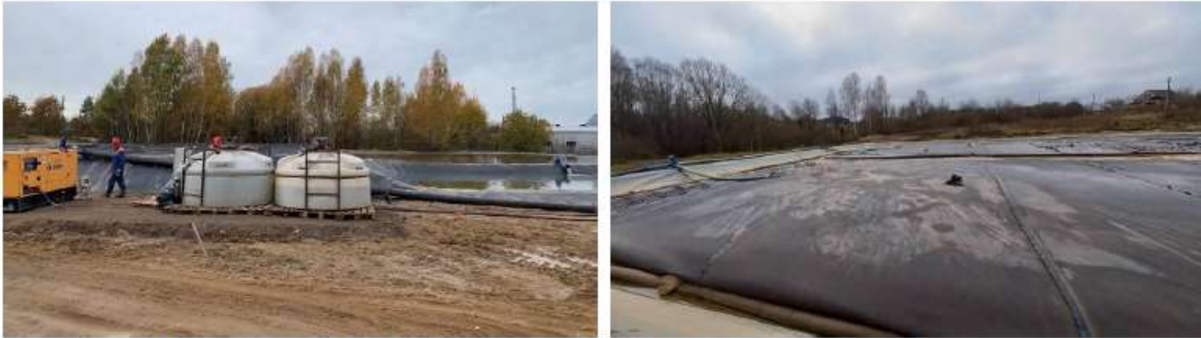
12 pav. Kairėje flokuliavimo maišymas, dešinėje grunto sausinsimo konteineriai.
